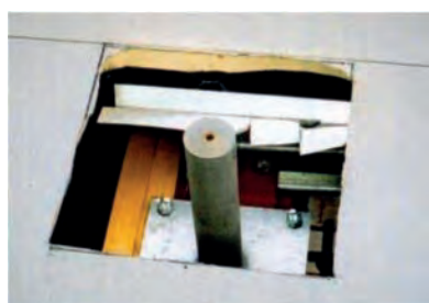
Tradycyjny słupek „montowany przez poszycie dachu”
